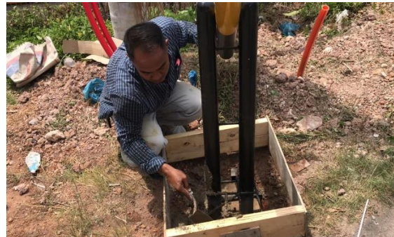
Gambar 1.3 Proses pemasangan portal jalan
