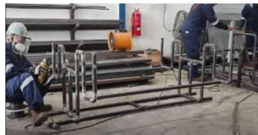
Gambar 16. Para Pekerja Sedang Melakukan Proyek
