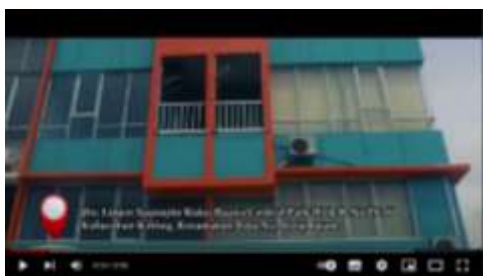
Gambar 8. Bangunan Laboratorium Klinik Osmaro
