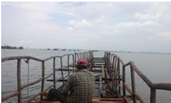
Gambar 3. Jembatan pada Hutan Mangrove Kelembak
