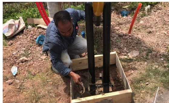
Gambar 1.3 Proses pemasangan portal jalan
