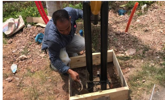
Gambar 1.3 Proses pemasangan portal jalan
