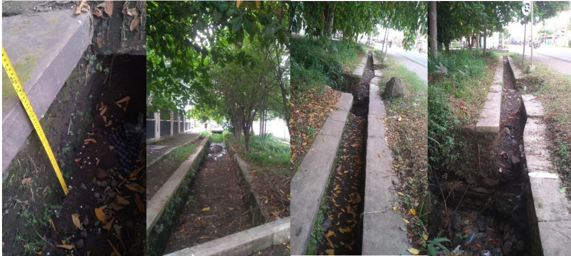
picture 1.6 STA 0+391 & STA 0+500
