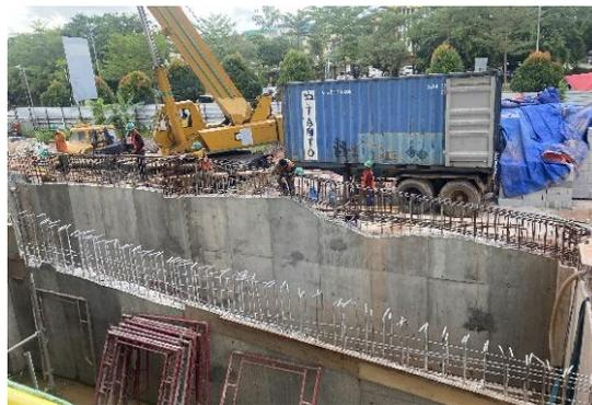
Gambar 4. Pekerjaan Pembesian Balok *Ramp*
