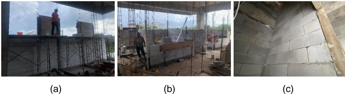
Gambar 2. (a, b, c) Pekerjaan Pasangan Bata Lantai 1, 2, 3.
