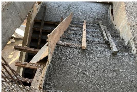
Gambar 5. Pekerjaan Pengecoran Tangga Lantai 1
