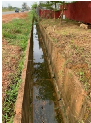
Gambar 3. Saluran u-ditch Sumber: Survey lapangan
