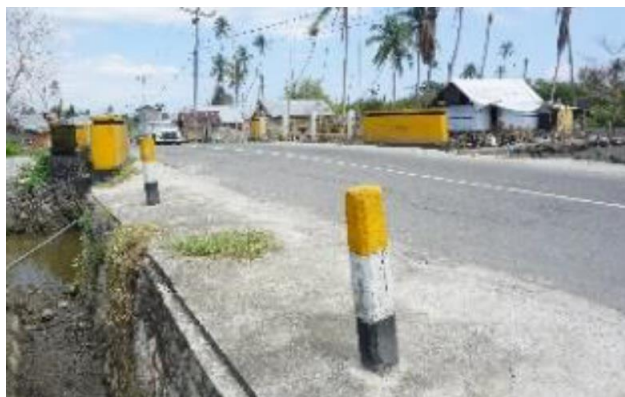
Gambar 9. Patok pengarah sebelum jembatan.
