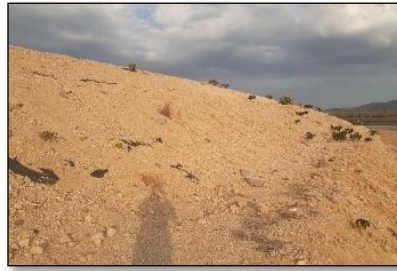
Gambar 2.1 Timbunan oprit jembatan labu sawo
