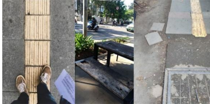
Gambar 9. Kondisi Fasilitas di Jalur Pedestrian Sumber: (Data Penelitian, 2019)
