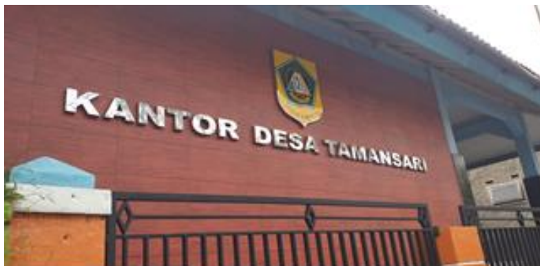
Gambar 1. Bangunan Kantor Desa Tamansari Sumber: Pribadi, 2019
