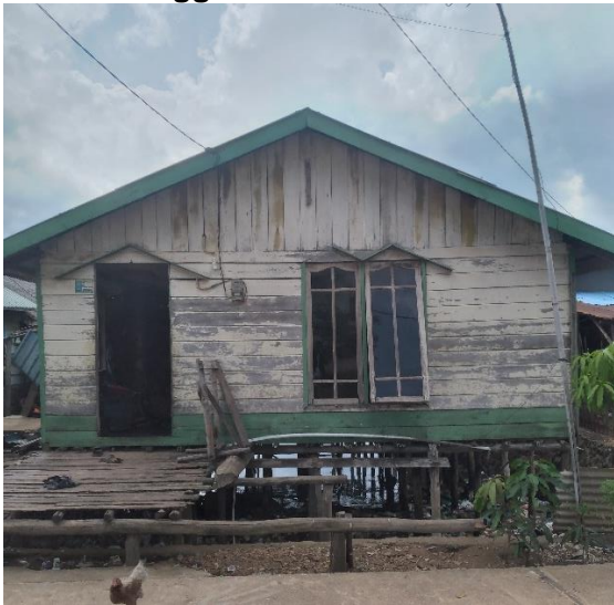
Sumber : Dokumentasi Penulis
