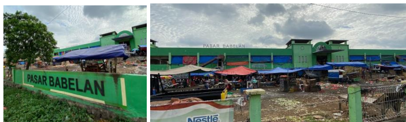
Gambar 1. Bangunan Pasar Babelan Sumber: (Pribadi, 2022)
