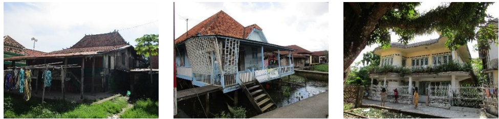
Gambar 6 Bangunan hunian pada zona III
