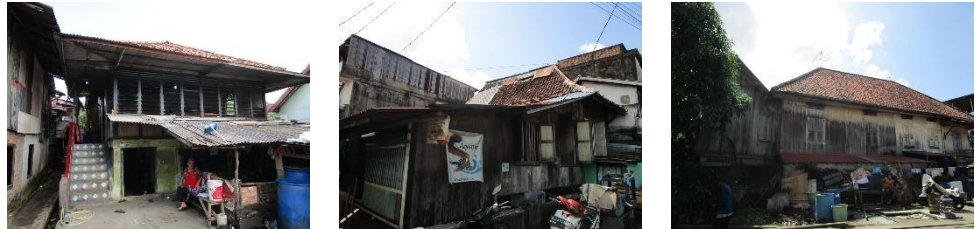
Gambar 4 Bangunan hunian pada zona I Sumber: observasi, 2022
