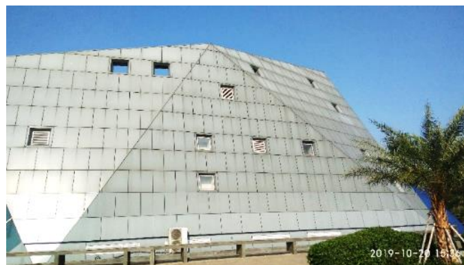
Gambar 5. Fasad Bangunan Masjid
