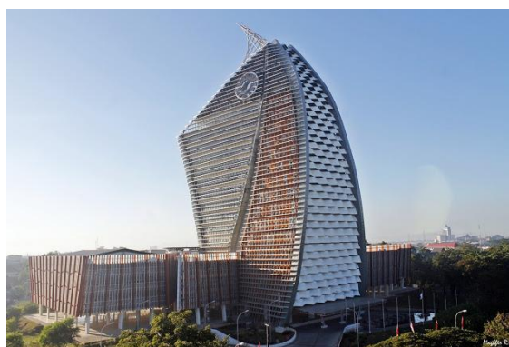
Gambar 1 Menara Pinisi UNM
