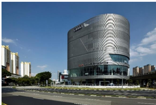
Gambar 1. Kondisi Eksisting Bangunan Audi Centre Sumber: Archdaily, 2020
