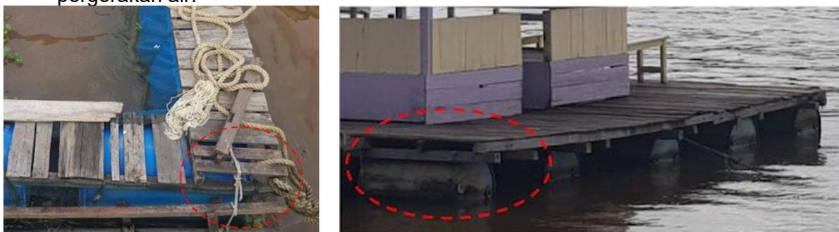
**Gambar 7.** Konstruksi Drum pada Struktur Apung di Lokasi Observasi
