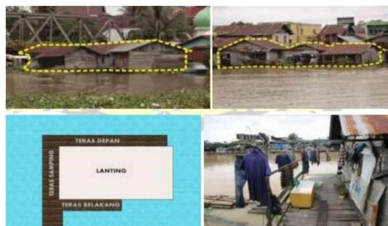
**Gambar 3.** Tipologi Bentuk Bangunan dengan Struktur Apung
