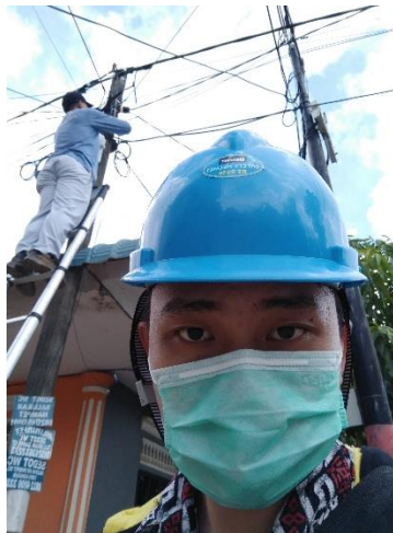
Gambar 3. Proses Penarikan Kabel
