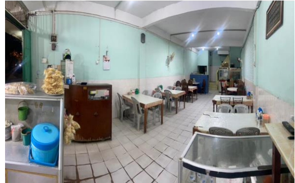
Sisi ke-1 dinding sebelum di cat
