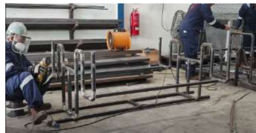
Gambar 16. Para Pekerja Sedang Melakukan Proyek
