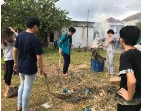
Gambar 4: Proses Pembersihan Lokasi
